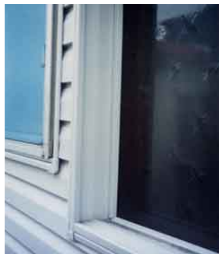
窓が奥まっている場合、本体を利用し、 Jチャンネルとトリムで納める コーナーはコーナーキャップを使用
