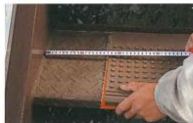
水切りのため、ステップの両端部から壁面まで20mm以上の隙間を確保してください。
