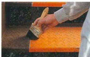
施工面のゴミ、ホコリ等を取り除き、下地が十分に乾燥していることを確認してください。
