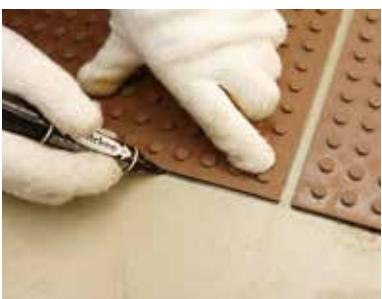
裁断した消音マットを規定の位置に仮置きし、納まりを確認した後、下地に位置決めのマーキングを記してください。
