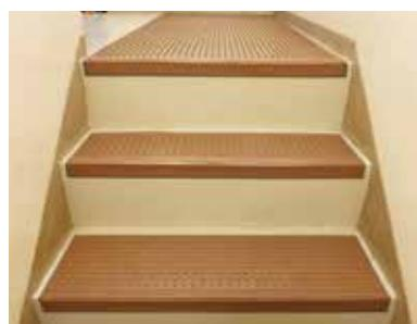
仕上げ後は本体の接着及びシーリング施工の有無を再確認ください。
