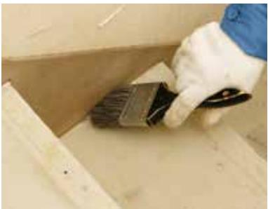
施工面のゴミ、ホコリ等を取り除き、下地が十分に乾燥していることを確認してください。
